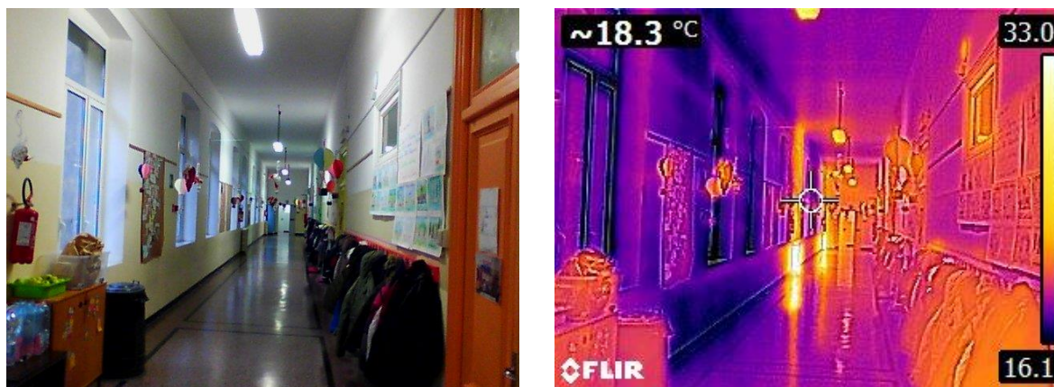
Figura 4.3 – Rilievo termografico della parete del corridoio
