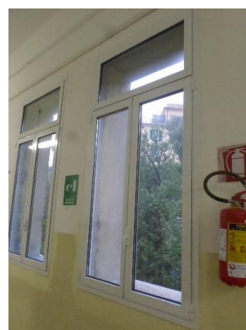
Figura 4.4 - Particolare dei serramenti del secondo piano
