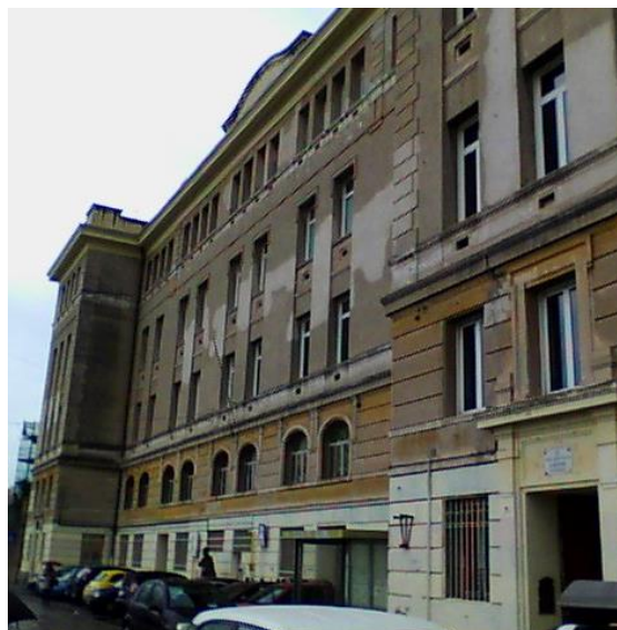
Figura 1.1 - Vista della facciata esposta a Est
