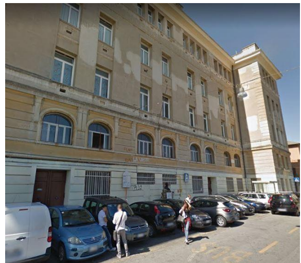
Figura 4.2 - Particolare della facciata
