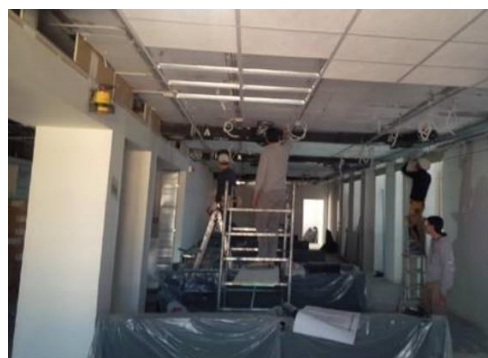
Figura 8.4- Particolare installazione controsoffitti
